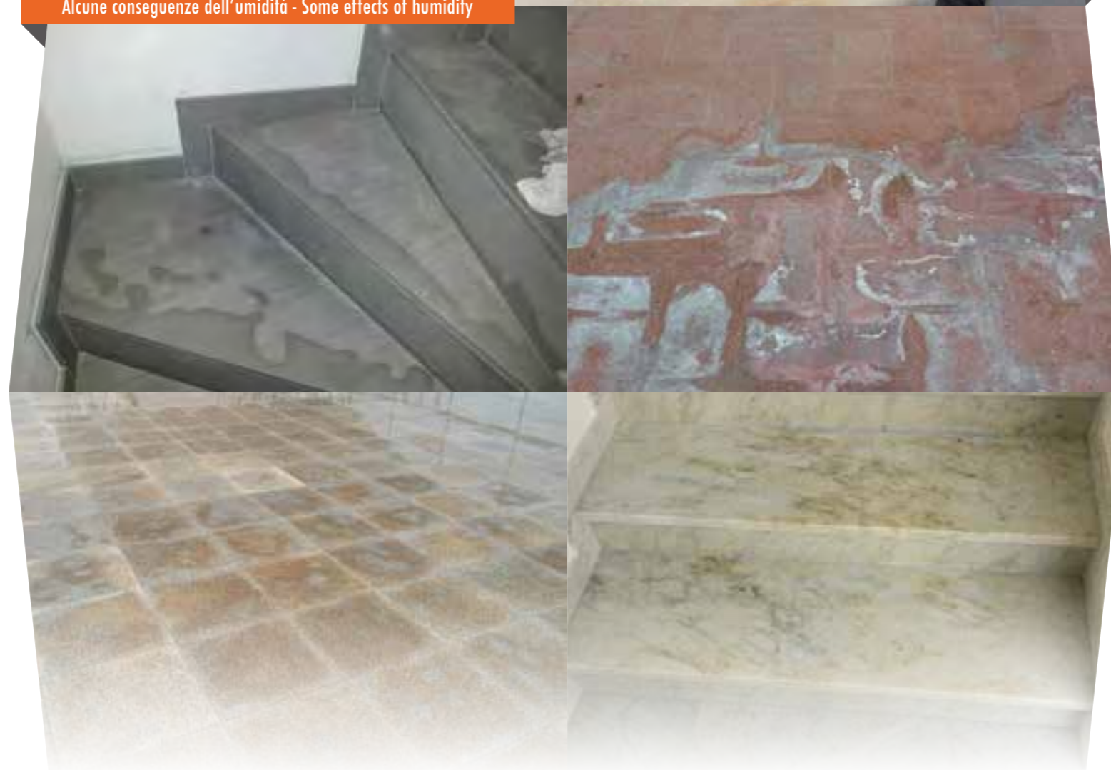
Alcune conseguenze dell'umidità - Some effects of humidity
